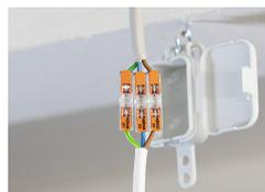
Raccordement de luminaires dans les faux-plafonds
